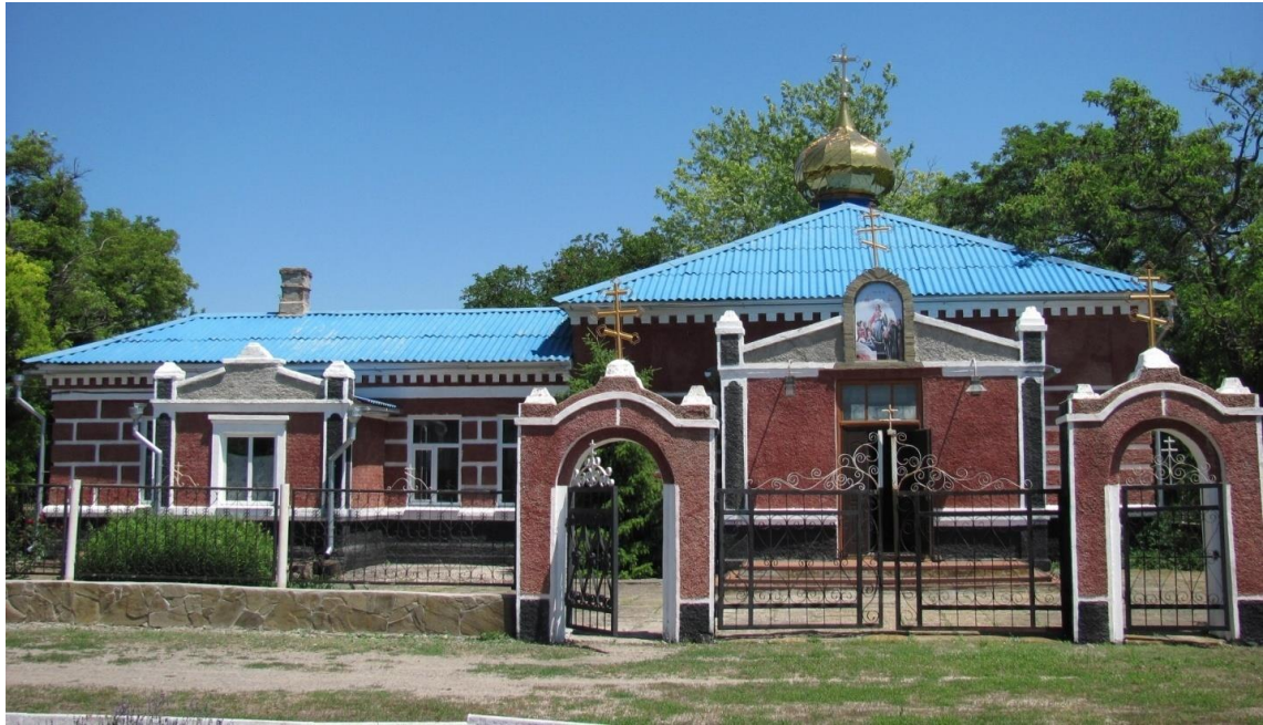
Свято-Успенский храм – современный вид здания
