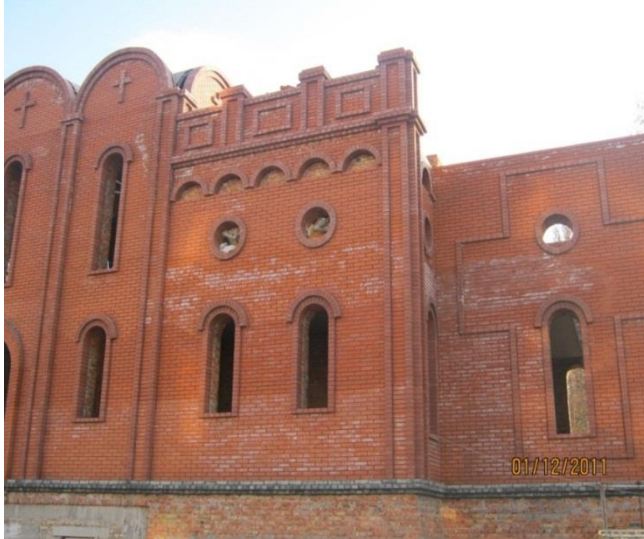
Внешний вид строящегося храма
